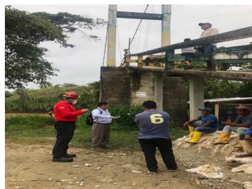
Inspección y coordinación para garantizar la seguridad en el puente rio Zamora-Manchinatza.
