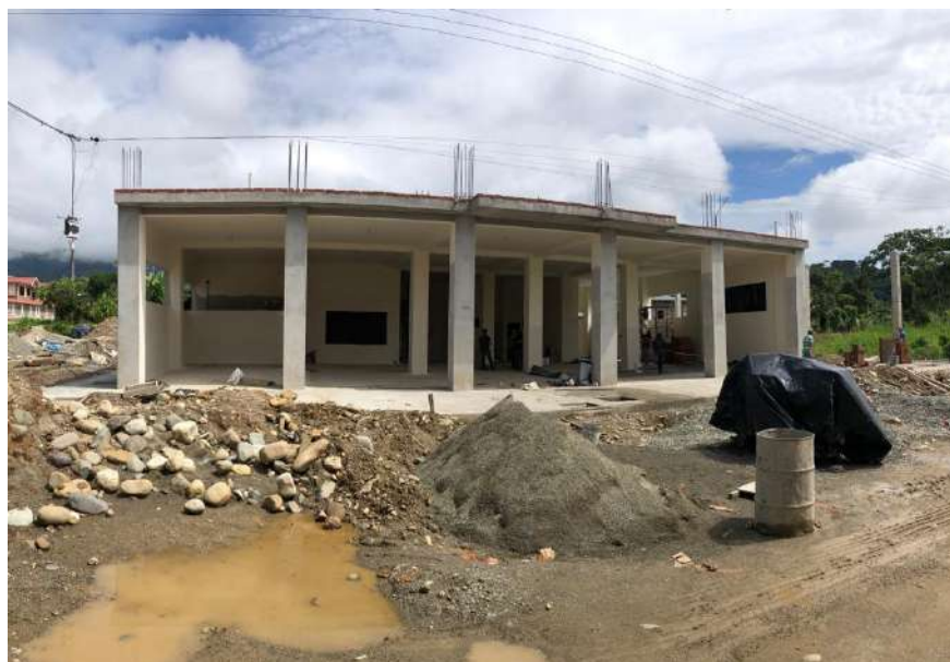
Situación actual de la Construcción de la primera fase de la Estación de Bomberos del Cantón el Panguí.
