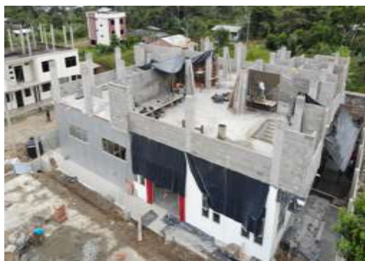
Inicio de la construcción de la segunda fase.
