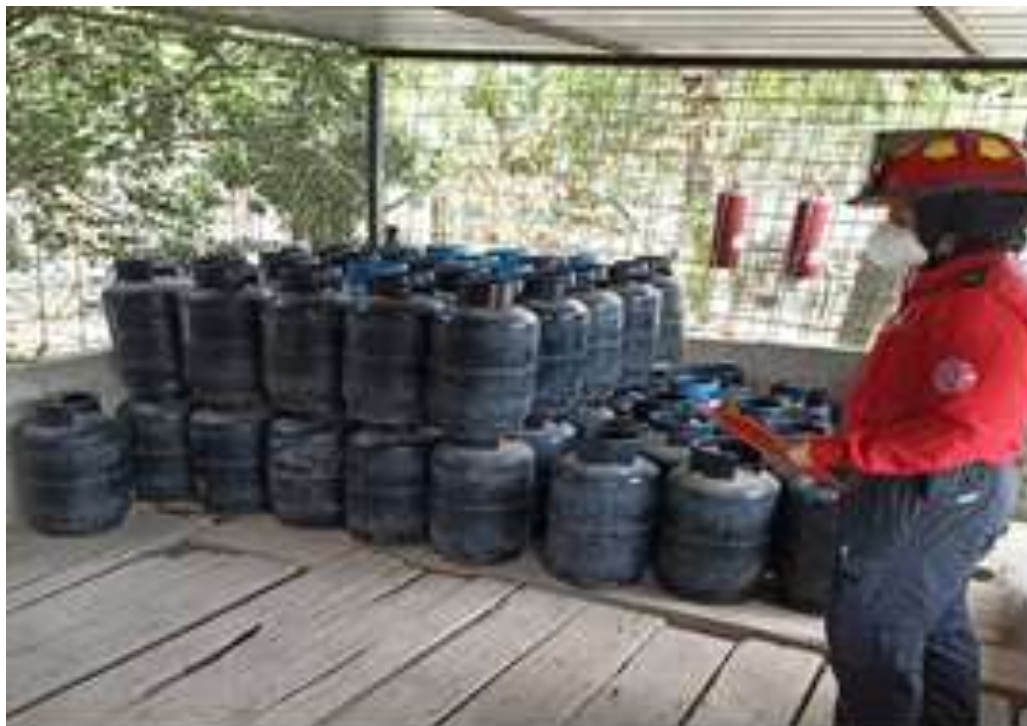
Inspecciones de depósitos de Gas.
